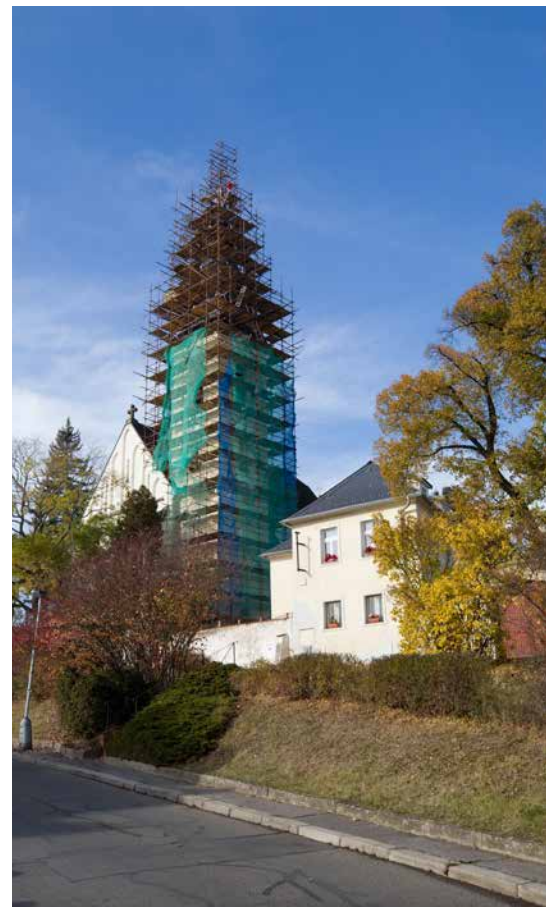
Oprava věže kostela sv. Jakuba Staršího, Praha-Stodůlky (foto archiv farnosti)
